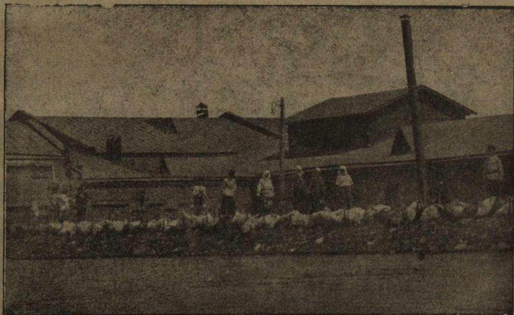
Die Rayonfabrik, gegen die Ueberschwemmung geschützt.
