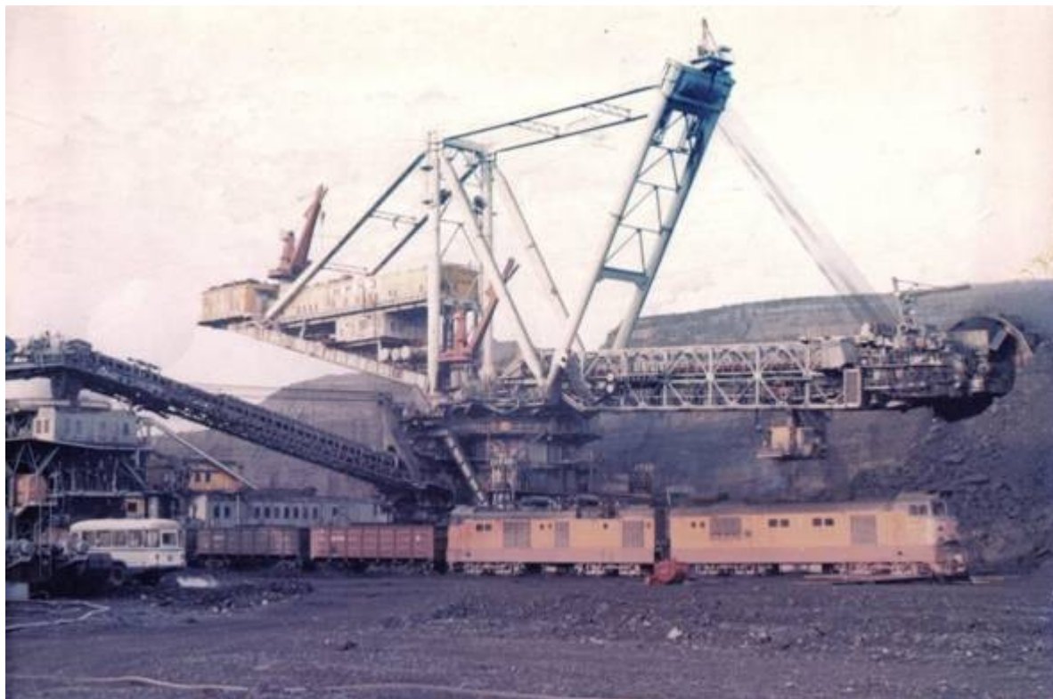
Роторный экскаватор для каменных углей производительностью 5000 тонн угля в час (Экибастуз, разрез «Богатырь»).
