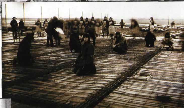
23. Заливка бетоном. 1931 г. (ЭКМ)
