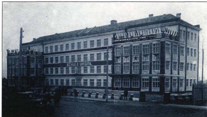
40. Здание после окончания строительства. (ЭКМ)
