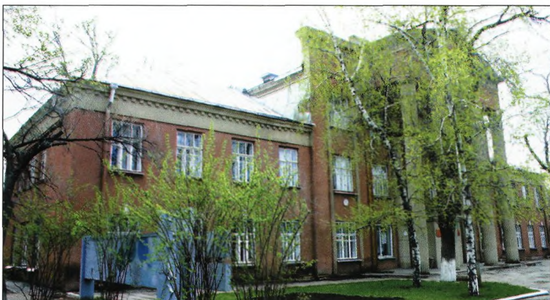
52. Современный вид здания. 2004 г. Фото Ю.Репина.
