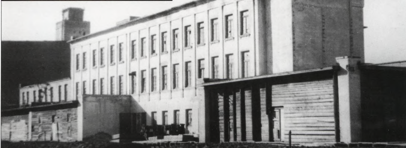
26. Верхнее фото - строительство бани-прачечной. 1932 г. Из архива Н. Мамонова.
