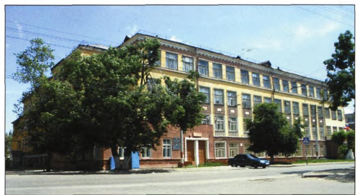
63. В этом здании (ул. Тельмана, 3) располагается музыкально-эстетический лицей. 2004 г. Фото Ю. Репина.
