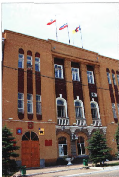
6. Фасад здания Администрации. 2004 г. Фото Ю. Репина.
