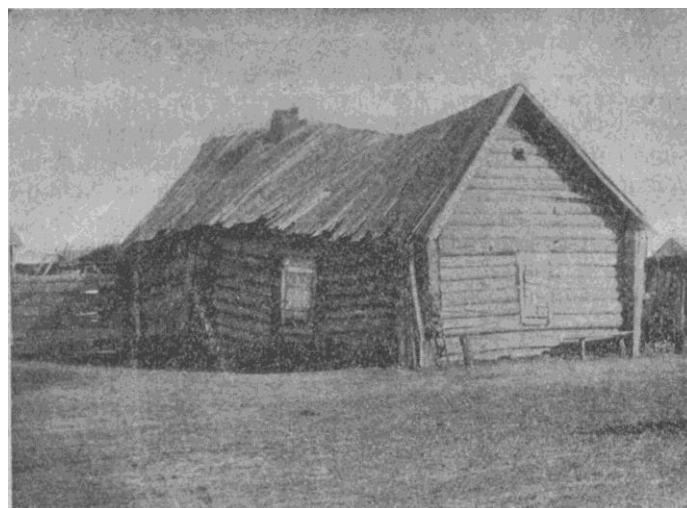
Коронный дом в Боргарде . Вид с теневой стороны. Фото 1908 г.
