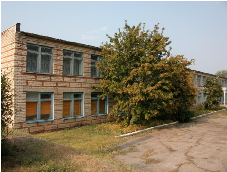
Рис. 27. Современное здание школы села Зоркино, ул. Ленина, 27. — Фото Н. Гусевой (Шмидт) и Г. Фенделя, август 2010 г.
